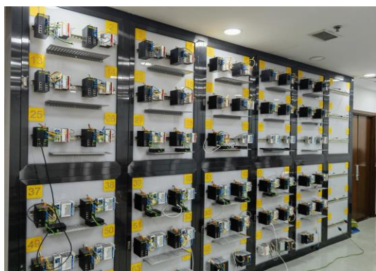
金风风电机组控制仿真中心
